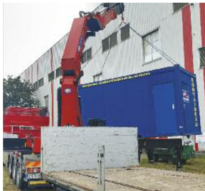
Montaż szatni kontenerowej.
